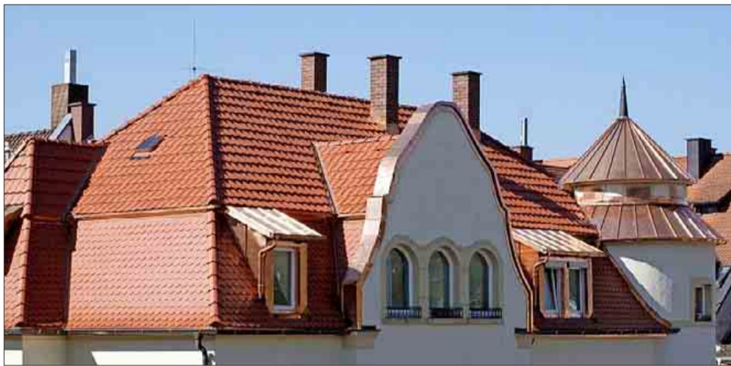
Inbesondere auf die energetische Sanierung alter, oft auch denkmalgeschützter Gebäude hat sich die Firma Krawczyk spezialisiert.
